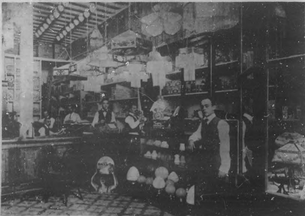
La "Island Electrical Supply".—Interior del establecimiento.
